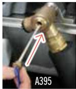
**Elektrisches Frostschutz-Set für das Ventil**
