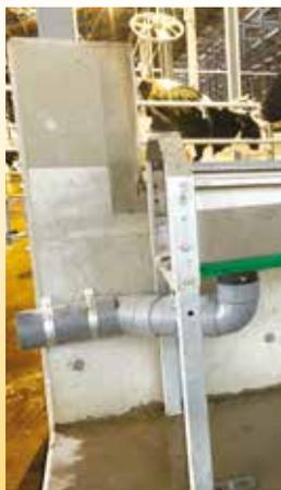
**Ablassschraube mit 100-mm-Durchmesser „trockene Hände“:**
